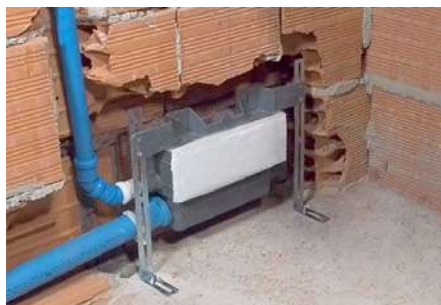
Aplicação em parede de alvenaria
