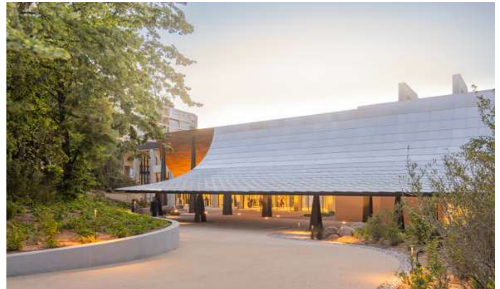
CENTRO DE ARTE MODERNA. Fundação Calouste Gulbenkian - Lisboa, Portugal — Arq. Kengo Kuma / ODDA Arquitetos THE MODERN ART CENTRE of the Calouste Gulbenkian Foundation - Lisbon, Portugal — Kengo Kuma, architect / ODDA Arquitetos
